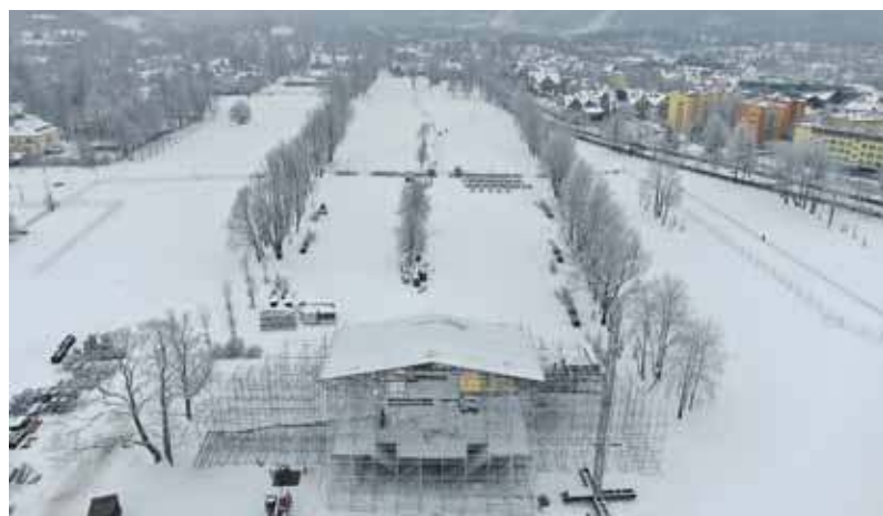
Budowa sylwestrowej sceny na Równi Krupowej idzie pełną parą.
