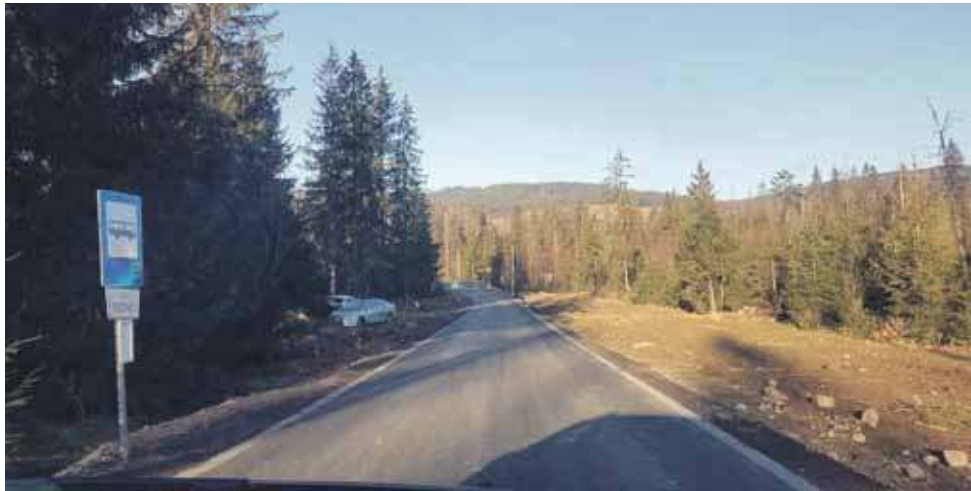
To początek remontu drogi w Roztokach. Gdy uda się uzyskać zgody właścicieli, wyremontowany ma zostać kolejny odcinek.
