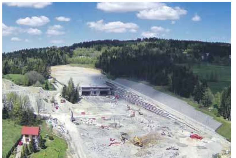
Zaawansowanie robót przy tunelu pod Luboniem Małym to 86% - ocenia GDDKiA.
