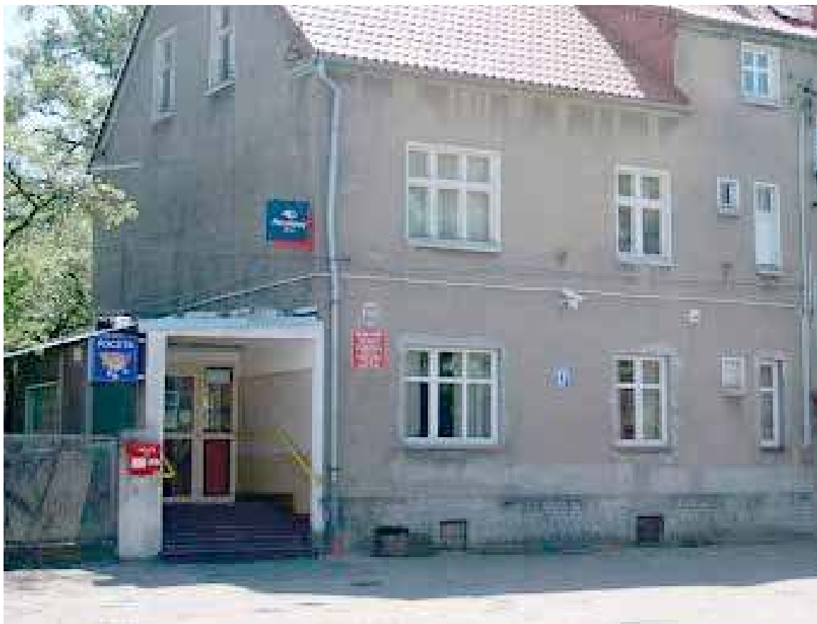
Budynek głównej siedziby Poczty przy ul. 3 Maja
