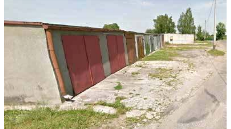
Przebudowany zostanie odcinek drogi przy garażach przebiegający od strony Zakładu Karnego
