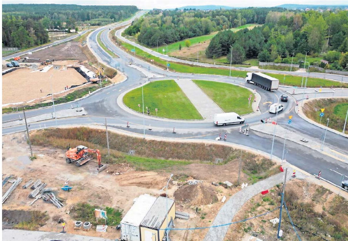
Organizacja ruchu jest zmieniana w zależności od prowadzonych prac. Rondo w Woli Morawickiej było nawet przez kilka dni udostępnione kierowcom, kiedy nie prowadzono tam robót
