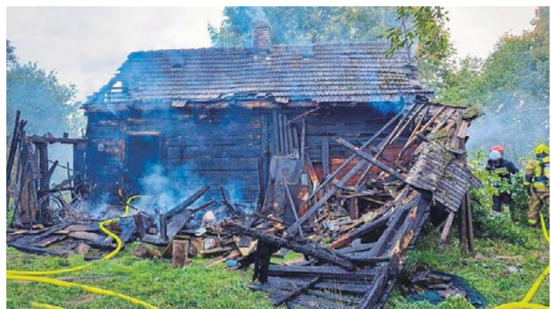
Dom w Rzechowie Starym w gminie Rzecznów uległ praktycznie całkowitemu zniszczeniu.
