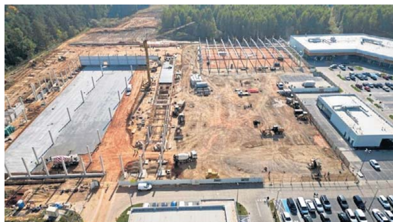
Na terenie centrum trwają prace. Z lewej strony widać powstający market Leroy Marlin. Z prawej - budynek handlowo-usługowy
