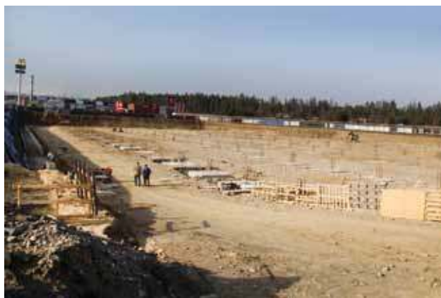
Postęp prac przy budowie Galerii Podhalańskiej.
