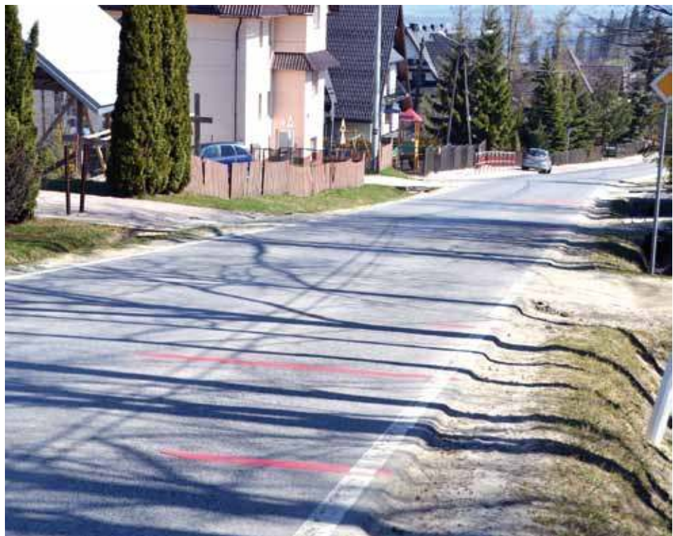
Pasy namalowane na drodze nie przyniosły oczekiwanego efektu.
