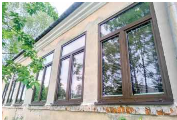
Wymienione zostały łącznie 23 okna i dwie pary drzwi zewnętrznych
