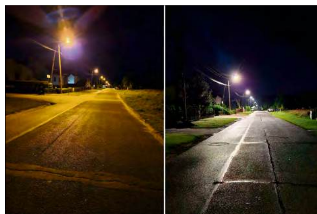
Na zdjęciach widać - przykładowo - ul. Słoneczną w Tarnowie Opolskim i efekt przed oraz po wymianie oświetlenia.
