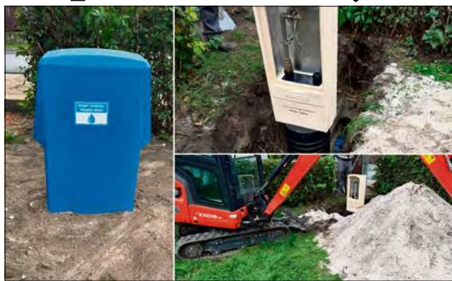
Montaż szafek do poboru próbek wody ma ograniczać wpływ wewnętrznych instalacji na jakość pobieranych próbek.
