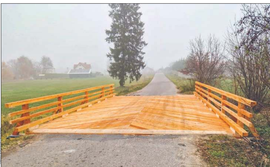
Zakres remontu obejmował wymianę konstrukcji drewnianej wraz z poręczami, a także dodatkowe wzmocnienie mostu
