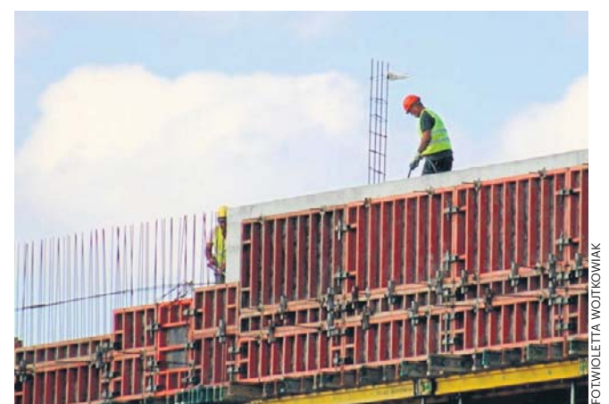
Mury nowego strażackiego centrum w Tarnobrzegu pną się szybko
