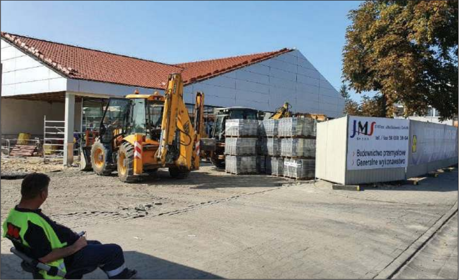
Trwa przebudowa garwolińskiego Lidla
