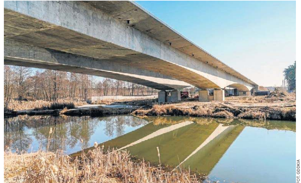
Gotowe są już konstrukcje dwóch estakad nad Czarną Nidą i nad Morawką. To najdłuższe estakady na sieci dróg krajowych w Świętokrzyskiem
