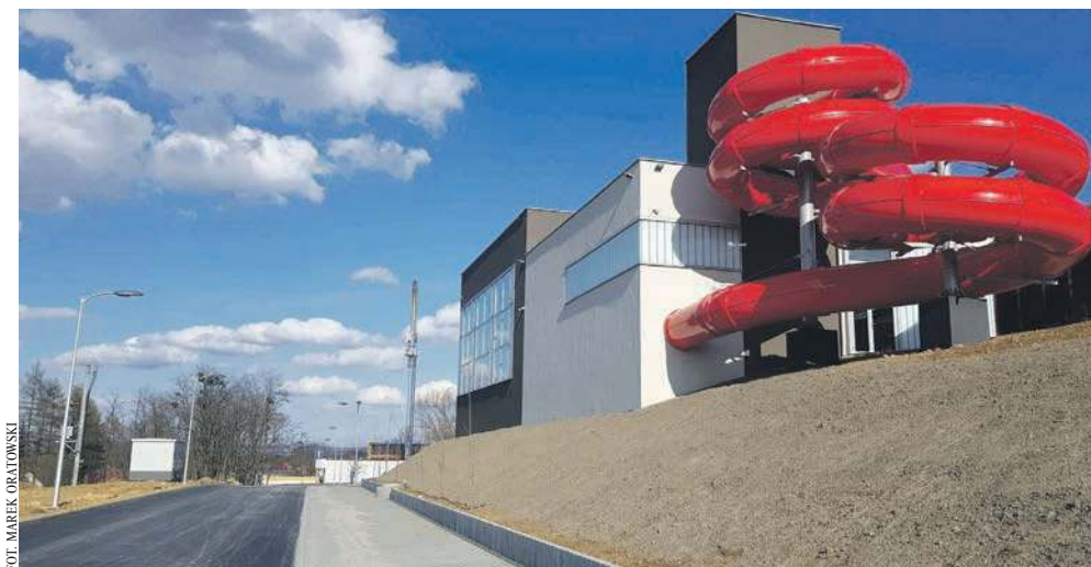
Przy basenie powstała nowa droga dojazdowa, otwierająca przy okazji tereny inwestycyjne. Więcej zdjęć i wideo z obiektu można obejrzeć na www.przelom.pl
