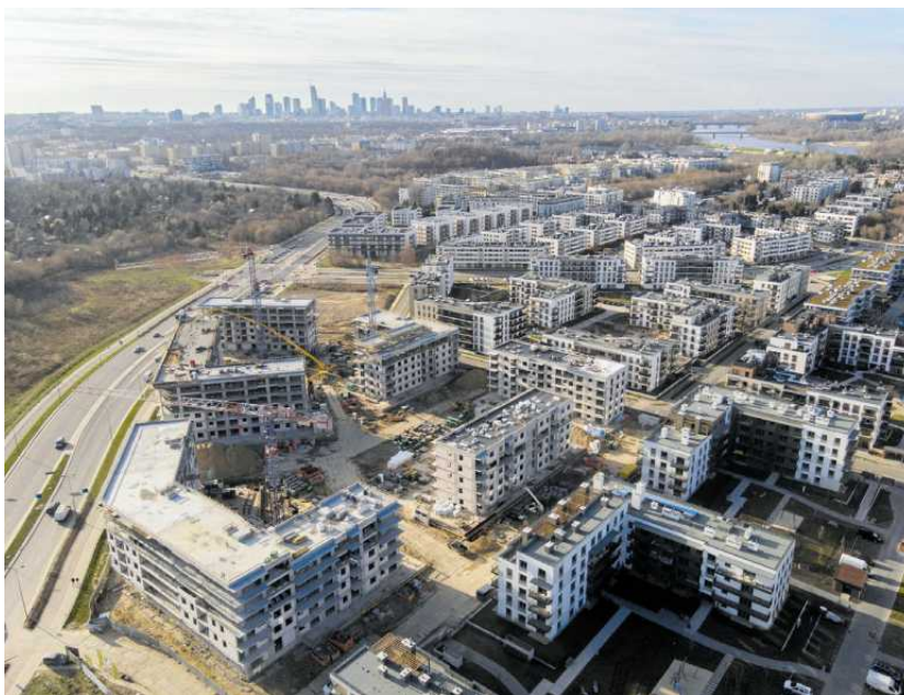
• Budowa nowych osiedli w Warszawie, marzec 2023 r.
