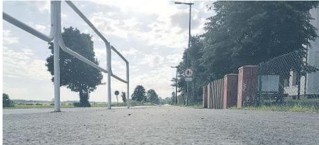
Budowa ciągu pieszo rowerowego w Woli Wereszczyńskiej
