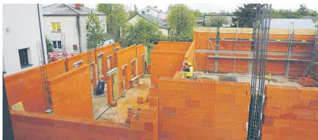
Budowa i przebudowa obiektu Biblioteki Gminnej w Urszulinie, fot. M. Kępa
