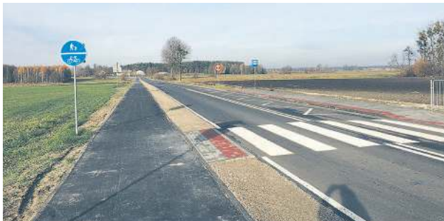
Andrzejów - przebudowa drogi powiatowej
