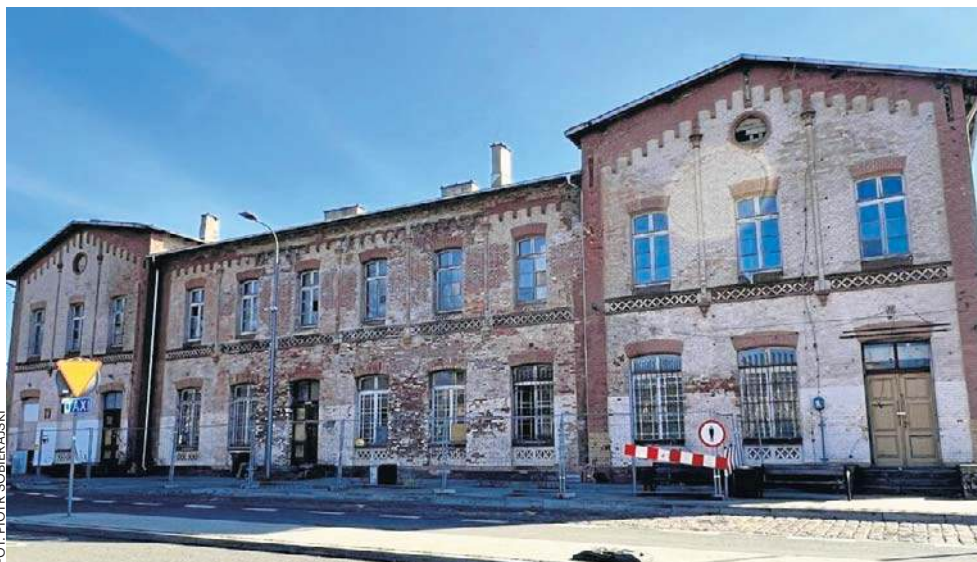
W 2011 roku niszczący budynek został ostatecznie zamknięty i wyłączony przez PKP S.A. z eksploatacji. Tak wygląda dziś, przed remontem
