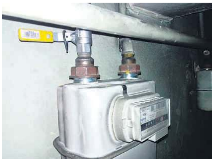
W czwartek, 13 grudnia, wymienione zostały zawory przy licznikach gazu.
