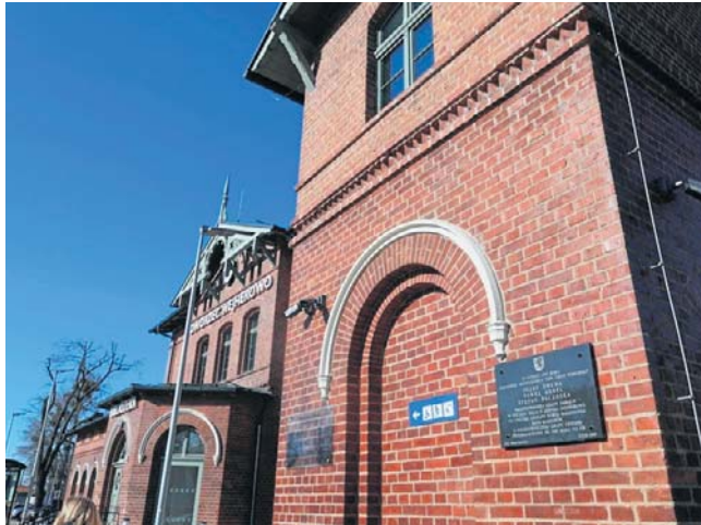
Remont samego budynku dworca został pozytywnie przyjęty, ale perony jeszcze pozostawiają wiele do życzenia
