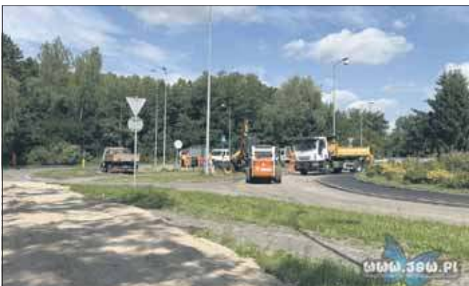
Prace nad rondem u zbiegu ulic Młynarskiej, Szelonka, Piaskowej i Lonty
