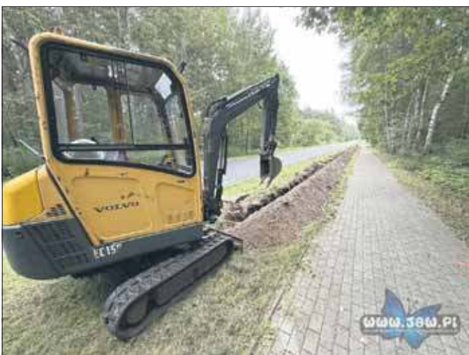
Prace nad montażem nowego oświetlenia ulicznego
