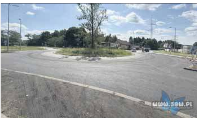
Wyremontowane rondo u zbiegu ulic Partyki, Chopina oraz Młynarskiej
