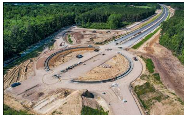
Lotnicze spojrzenie na plac budowy drogi ekspresowej S19 między Malewicami a Chlebczynem, gdzie prace wkraczają w decydującą fazę
