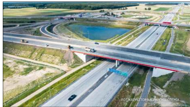
Blisko 140 km – tyle liczy łączna długość wybudowanej autostrady A2 od węzła Lubelska do węzła Biała Podlaska. Koszt inwestycji to 4,6 miliarda złotych
