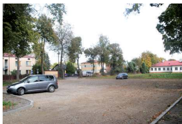
Budowa parkingu przy ul. Kolejowej rozpoczęła się w połowie września. I zgodnie z umową wykonawca miał zostać ukończona do końca października. Zakończyły się jednak wcześniej
