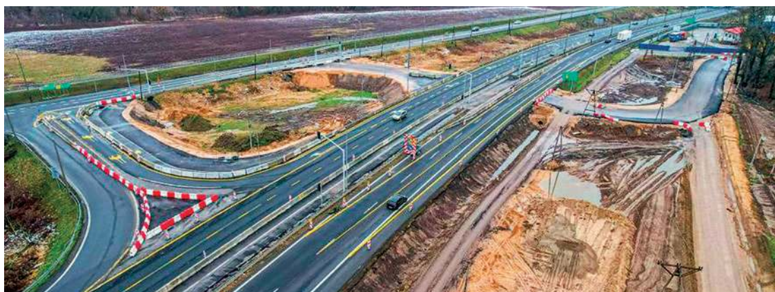
Roboty drogowe na „siódemce” są już bardzo zaawansowane
