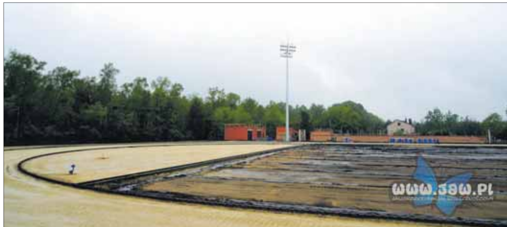
Budowa stadionu lekkoatletycznego w Jaworznie
