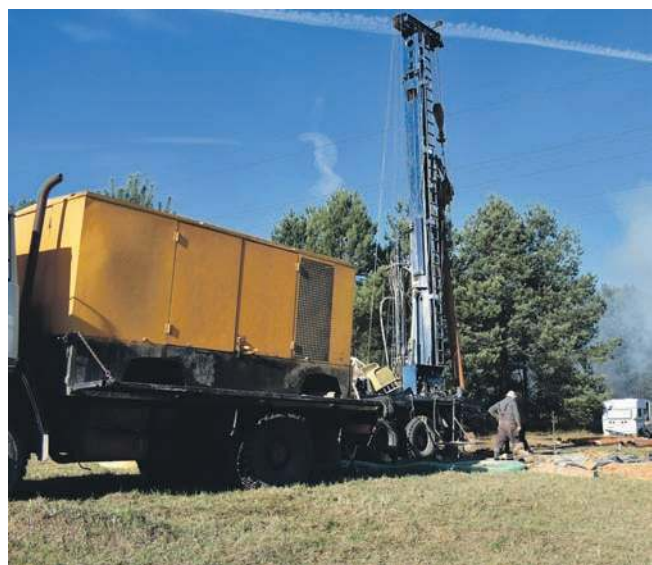
W Czyżówce na zlecenie Wodociągów Chrzanowskich wykonano już niezbędne odwierty
