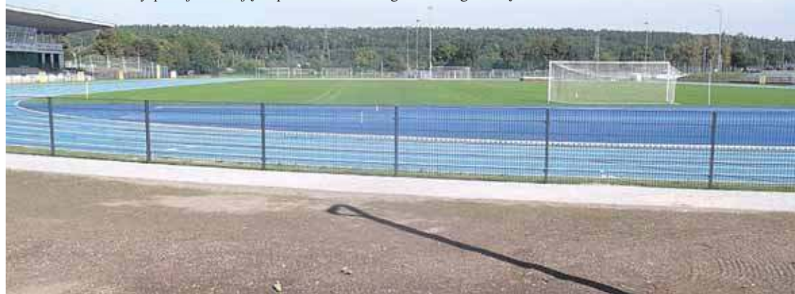
Na zmodernizowanym mławskim stadionie w oczy rzuca się przede wszystkim bieżnia w kolorze błękitnym
