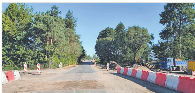
Trwa przebudowa dróg w Wysokim i Tuliłowie
