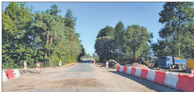
Trwa przebudowa dróg w Wysokim i Tuliłowie
