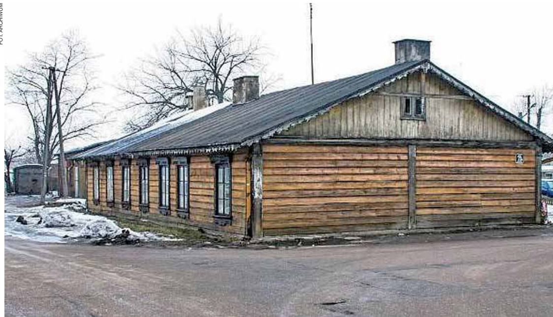
Zabytkowy budynek kolejowy postawiono w 1880 r.
