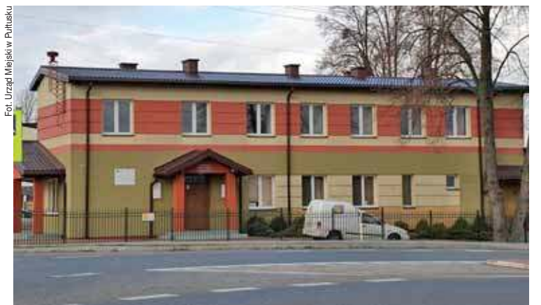
Dach świetlicy został naprawiony
