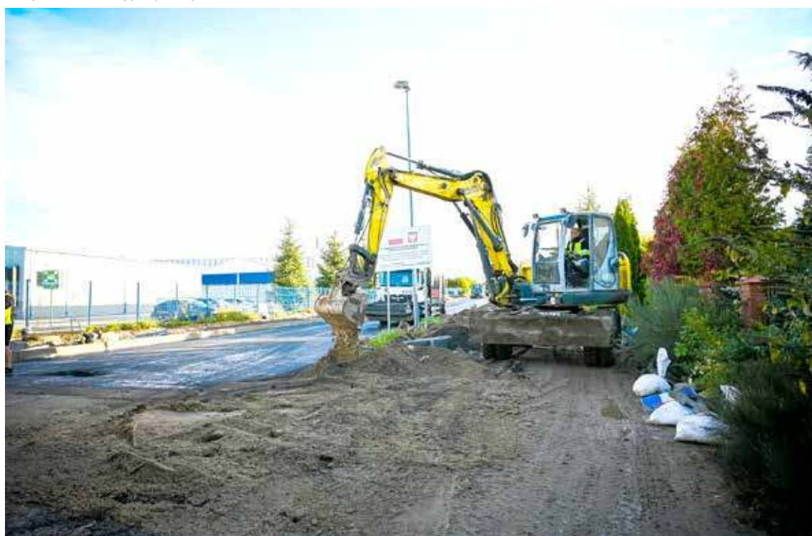
Tak wyglądają prace na ulicy Hanzeatyckiej w ramach budowy obwodnicy. Fot. Sebastian Ler.
