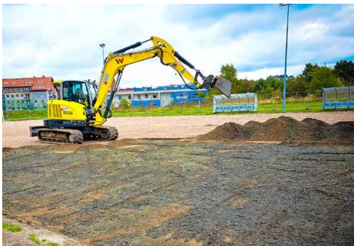
Trwają prace na boisku przy Armii Krajowej
