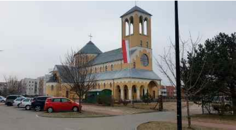
Jeden z naszych Czytelników zwrócił uwagę, że kościół Świętej Kingi wciąż jest w budowie i pyta czy organizowanie w nim koncertów nie jest sprzeczne z prawem budowlanym?
