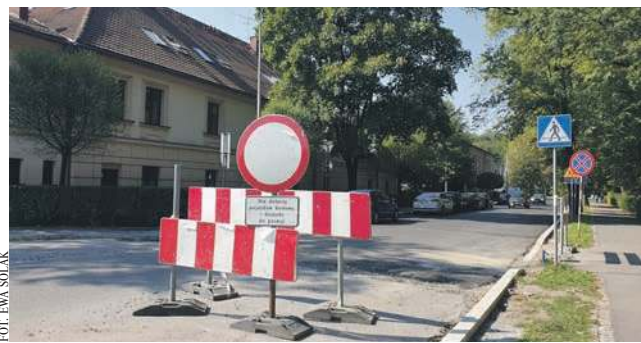
Ul. Ogrodowa w Krzeszowicach, gdzie nie skończono kłaść asfaltu
