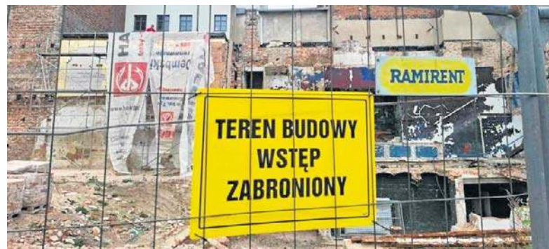
Po półrocznej przerwie prace w Starym Browarze zostały wznowione
