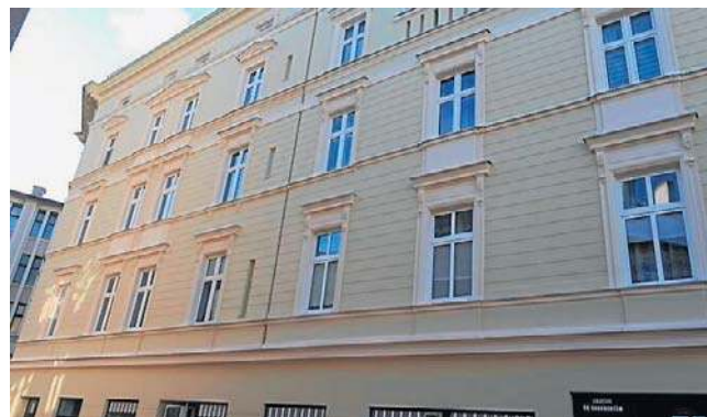
Pół mln zł pochłonęły prace pierwszego etapu renowacji kamienicy u zbiegu Dworcowej i Pomorskiej.
