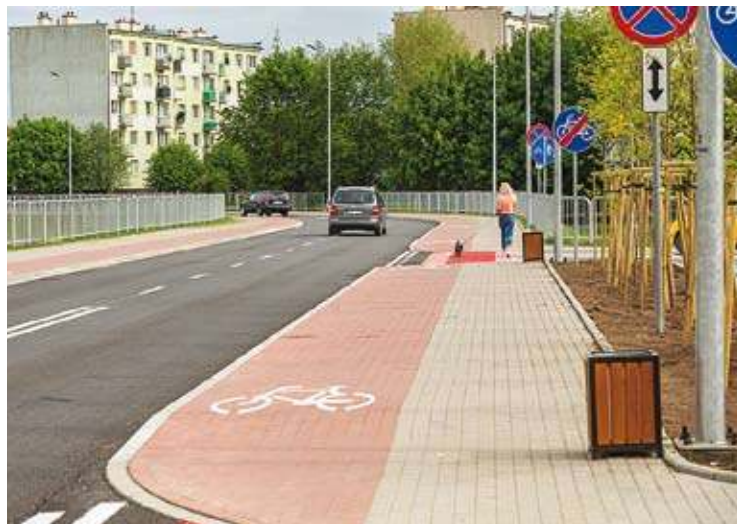
Fragment oddanej niedawno do użytku obwodnicy w centrum miasta
