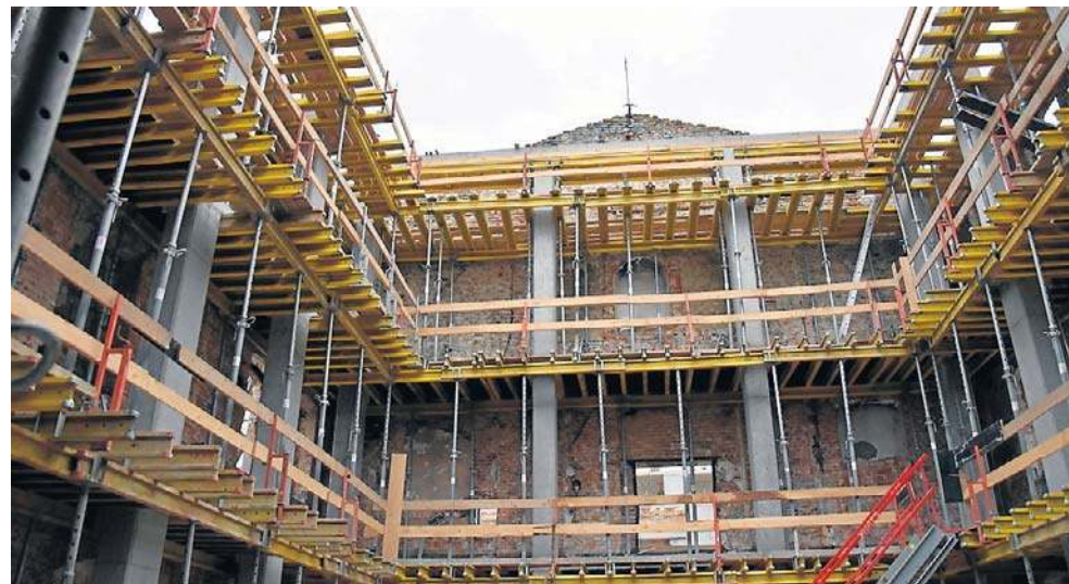
Mury są odbudowywane i wzmocniane specjalnymi konstrukcjami z żelbetonu
