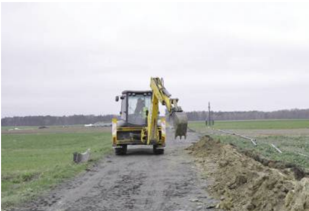
Prace remontowe na gminnych drogach
