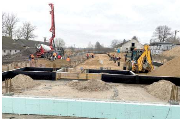
Z miesiąca na miesiąc budowa w Radoryżu Smolanym będzie rosła
