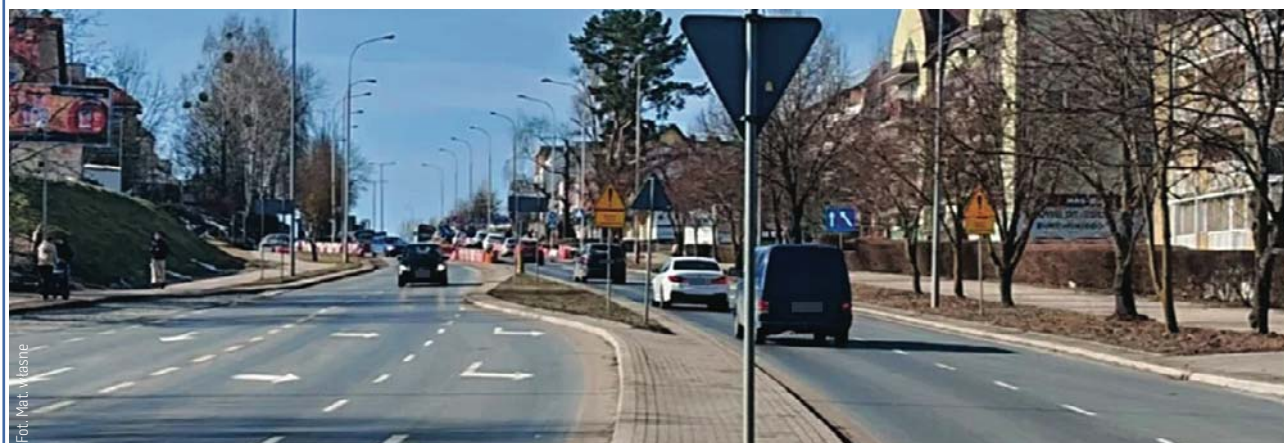
Fragment ul. Wilczyńskiego zostanie przebudowany
