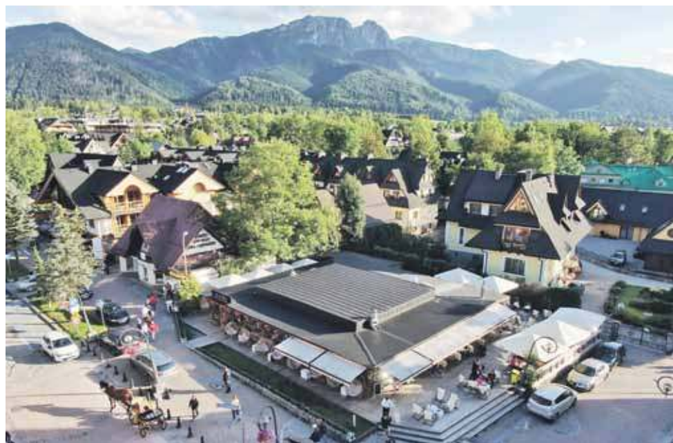
Nowy budynek ma stanąć na miejscu parterowej restauracji przy Oczku Wodnym. Kiedyś stała tu stacja CPN.
