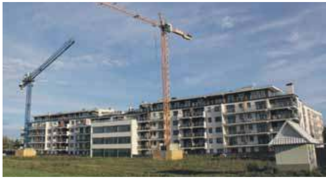
Blok przy Polanie Szaflarskiej zyska trzech sąsiadów.
