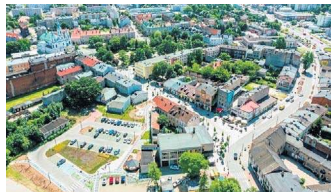
Już można przygotowywać wnioski o dotacje na prace konserwatorskie, restauratorskie i roboty budowlane
