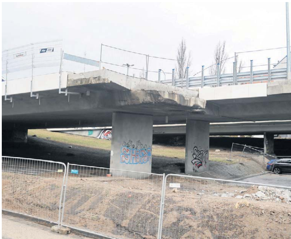
SIM informuje, że rozbiórka łącznic TZ została przeprowadzona zgodnie z obowiązującymi przepisami, przy zachowaniu oszczędnego i racjonalnego wydatkowania pieniędzy
