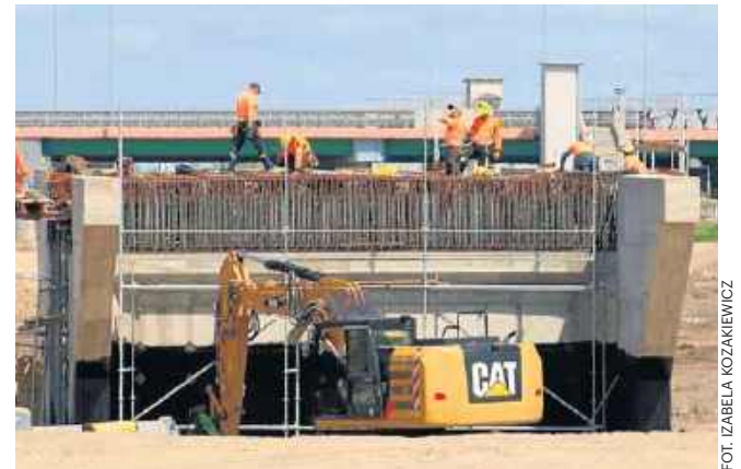
Nowy wiadukt w ciągu trasy N-S jest budowany nad ulicą Gołębiowską. Trwa zbrojenie płyty głównej.
