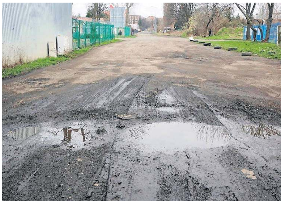
W latach 2026-2027 przebudowane będą ulice Senatorska i Przemysłowa (na zdjęciu)
