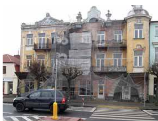
Obiekt wymaga szybkiego remontu
