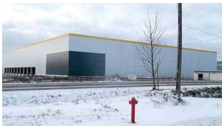
Hala magazynowa w Szydłowie, stan obecny
