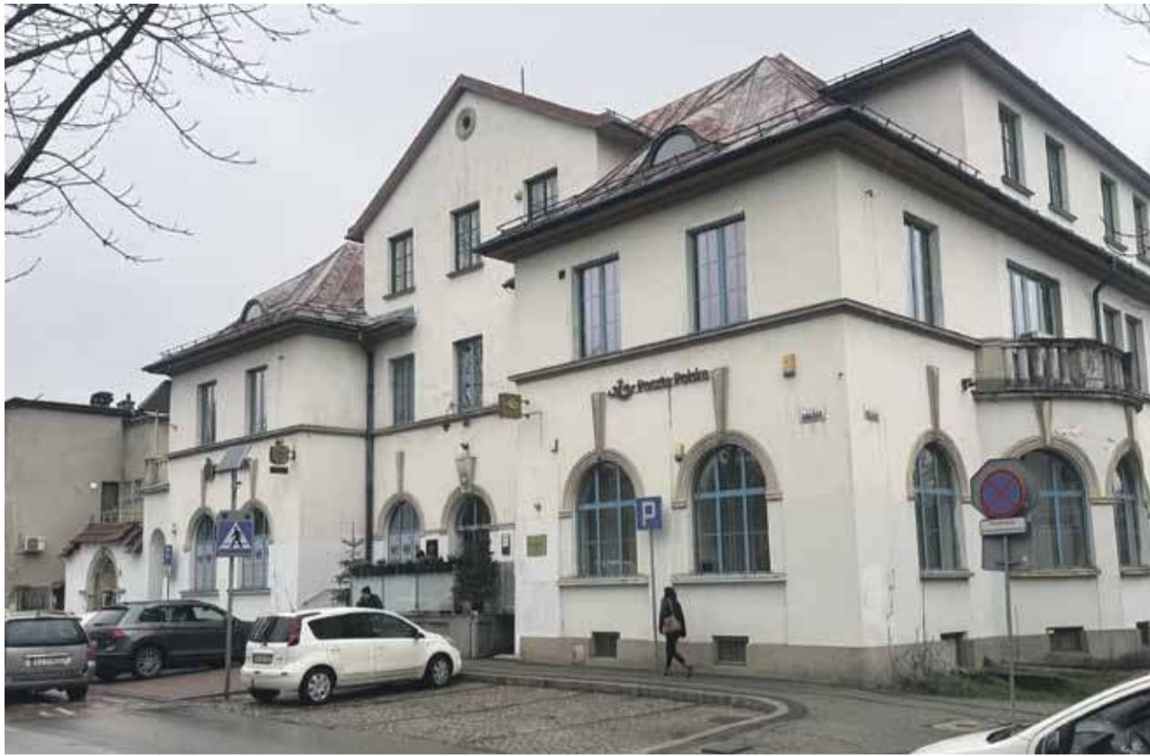
Budynek poczty w Rabce
