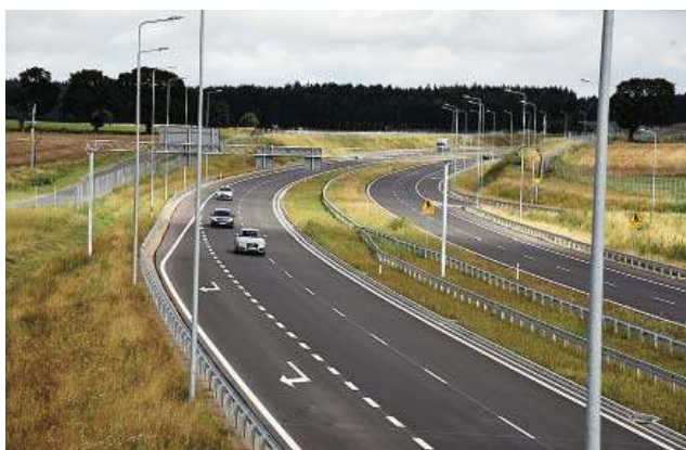
Początkiem drogi ekspresowej S5 w naszym regionie jest wybudowany już odcinek Ornowo – Wirwajdy
