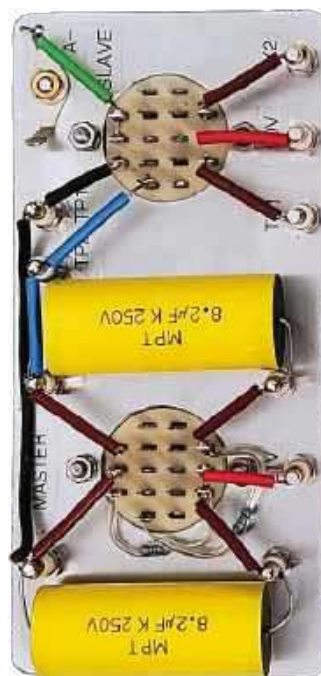
Zdjęcie 11 (po prawej): Spodnia strona przyrządu do testowania i regulacji przełączników. Widac elementy i okablowanie tworzące generator na dwóch przełącznikach
