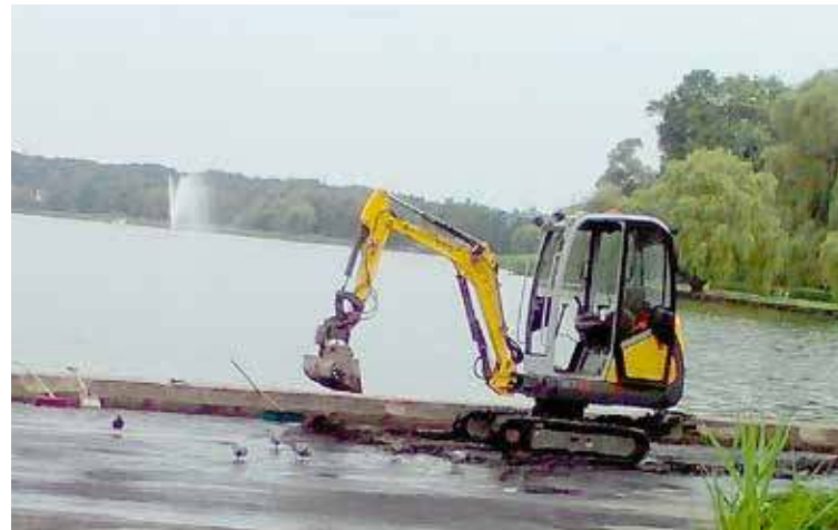
Prace porządkowe na terenie przy jeziorze w piątek
