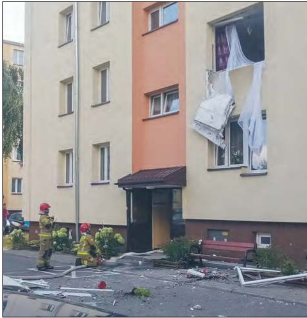
Na ulicy Stacyjnej w bloku pięciokondygnacyjnym nastąpił wybuch gazu na pierwszym piętrze. W wyniku zdarzenia jedna osoba została poszkodowana
