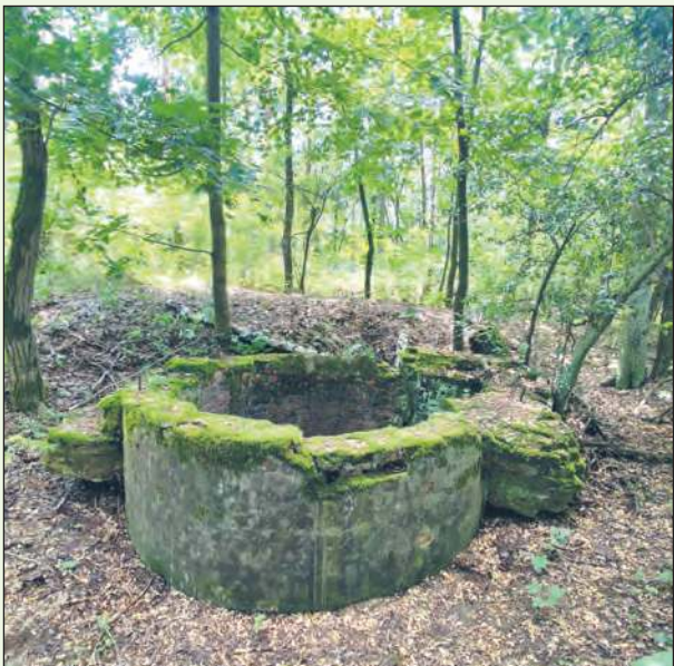
Dziś po gorzelni pozostały fragmenty fundamentów i duża murowana studnia o średnicy 2,5 m.
